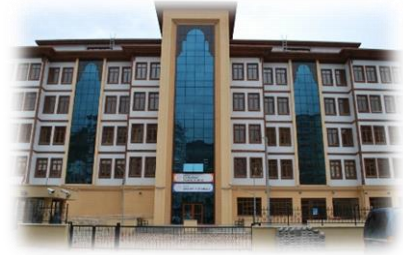
Okulun Üçüncü Binası (Güncel Okul Binası)
